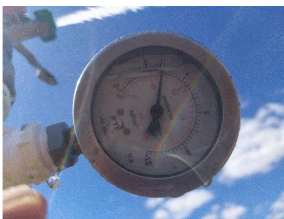
Figura 7- Aferindo a pressão de serviço do aspersor com auxílio de manômetro
