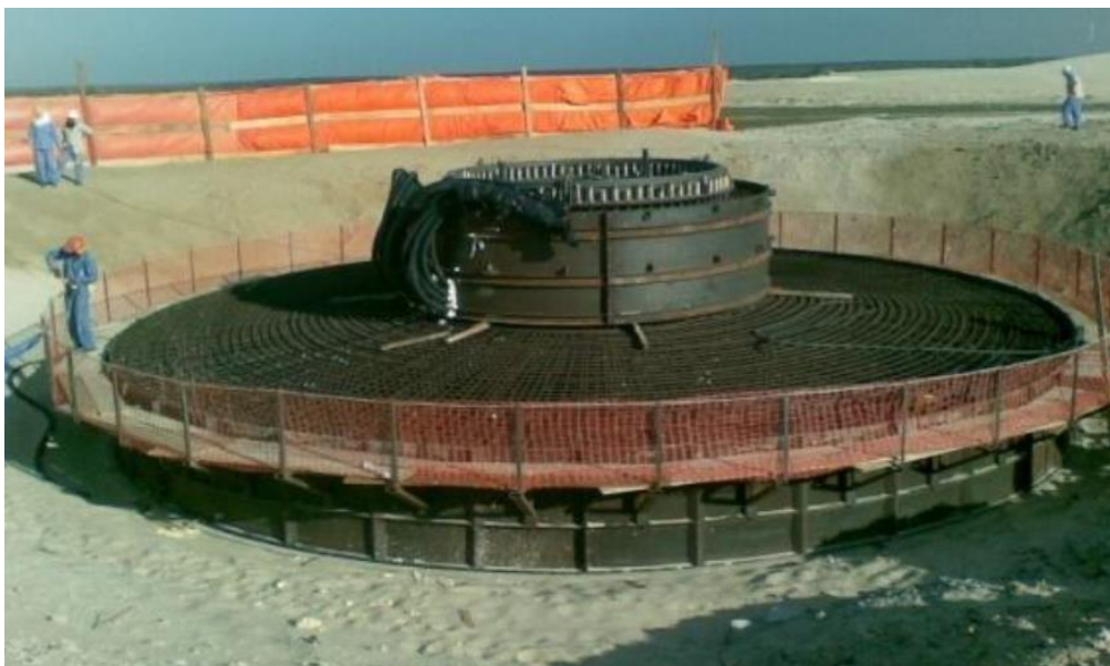
Figura 8 - Estrutura base que sustenta o aerogerador, em construção
