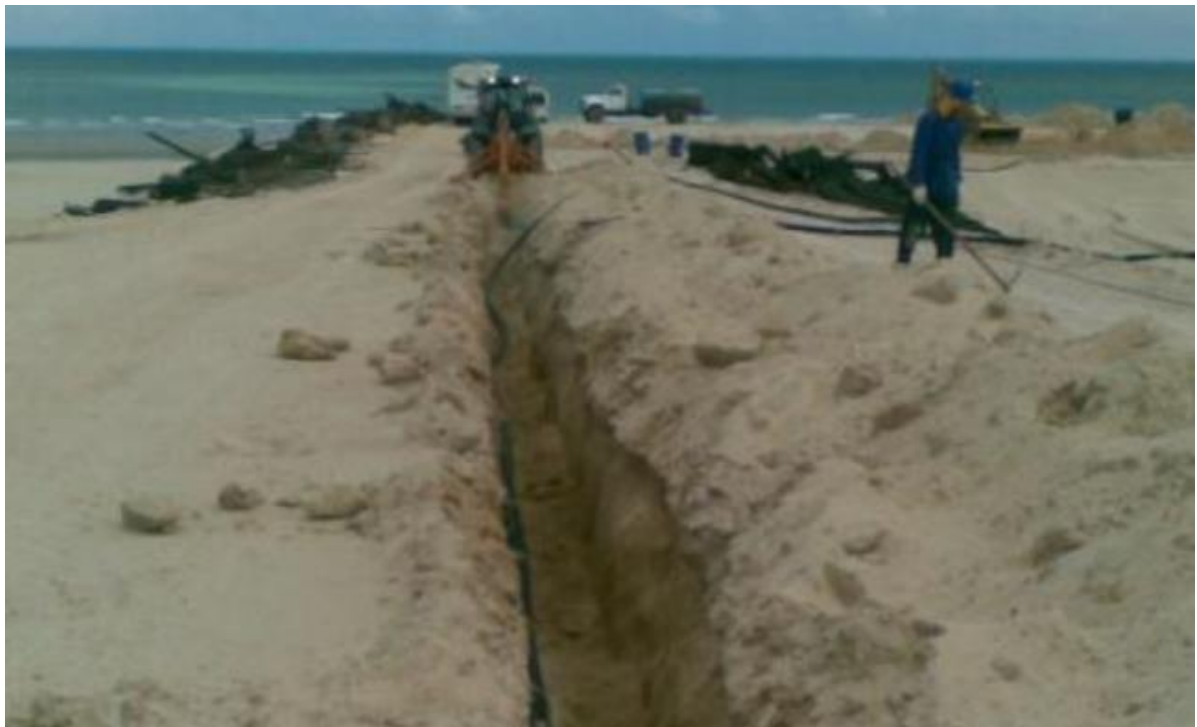
Figura 11 - Abertura sendo preparada para receber os cabos
