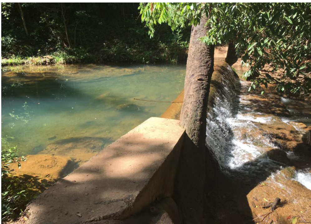
Figura 21 – Barramento para captação de água no trecho entre os pontos 1 e 2 do Riacho Canabrava
