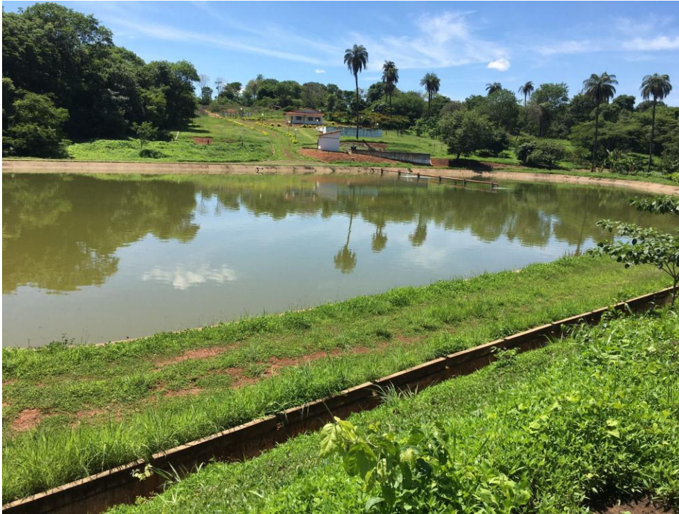
Figura 24 –Estação de tratamento de Esgotos da cidade de Coração de Jesus-MG
