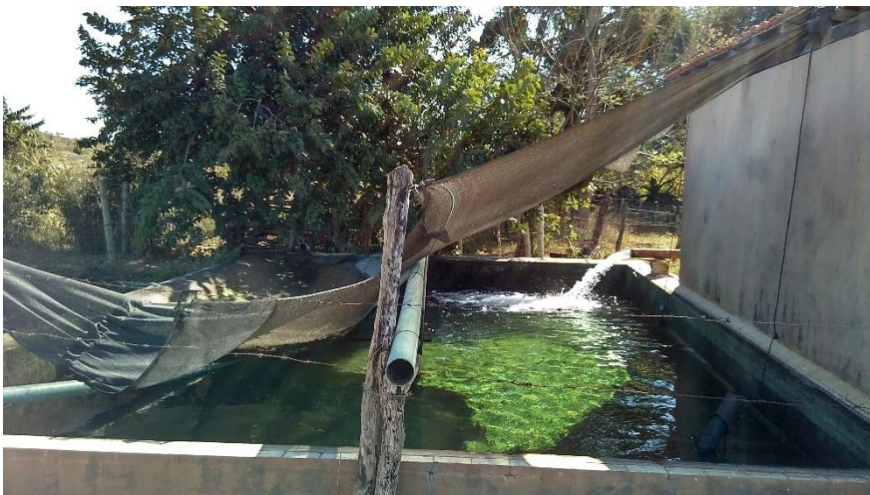
Figura 05 – Reservatório sem cobertura adequada.
