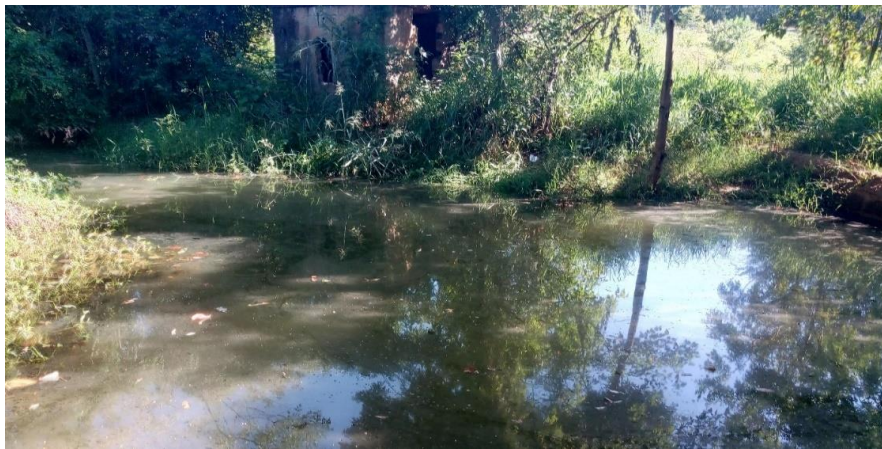
Figura 06 – Construção irregular nas margens no trecho A da microbacia do rio do Cedro
