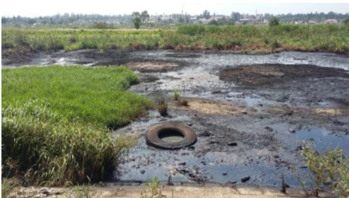
Figura 14 - Vista da lagoa facultativa F1 da ETAR de Infulene, Maputo, Moçambique
