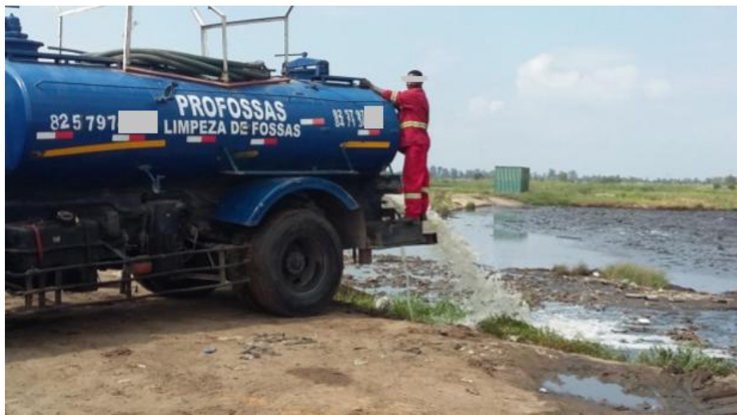
Figura 12 - Despejo de águas residuárias oriundas de fossas na lagoa anaeróbia A1 da ETAR de Infulene, Maputo, Moçambique
