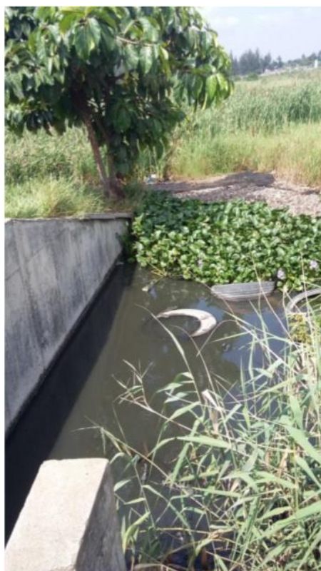
Figura 13 - Ponto de passagem do efluente da lagoa anaeróbia A2 para a lagoa facultativa F2 da ETAR de Infulene, Maputo, Moçambique
