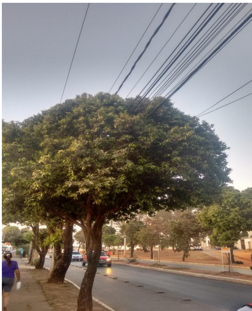
Figura 13 - Fiação na copa de árvore da avenida
